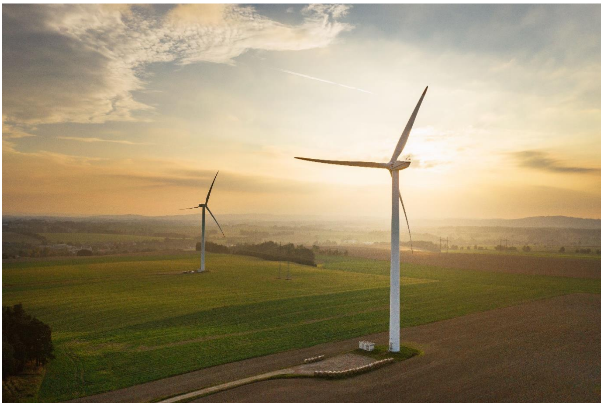
Větrné elektrárny ve vlastnictví skupiny ČEZ ve Věžnici na Vysočině
