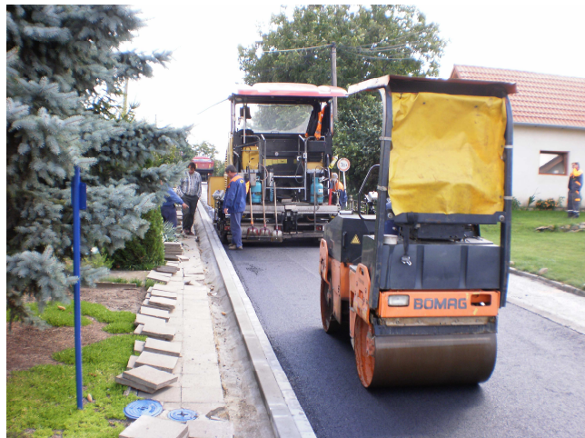
Oprava místní komunikace
