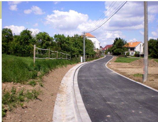
Dokončená oprava místní komunikace –III. etapa
